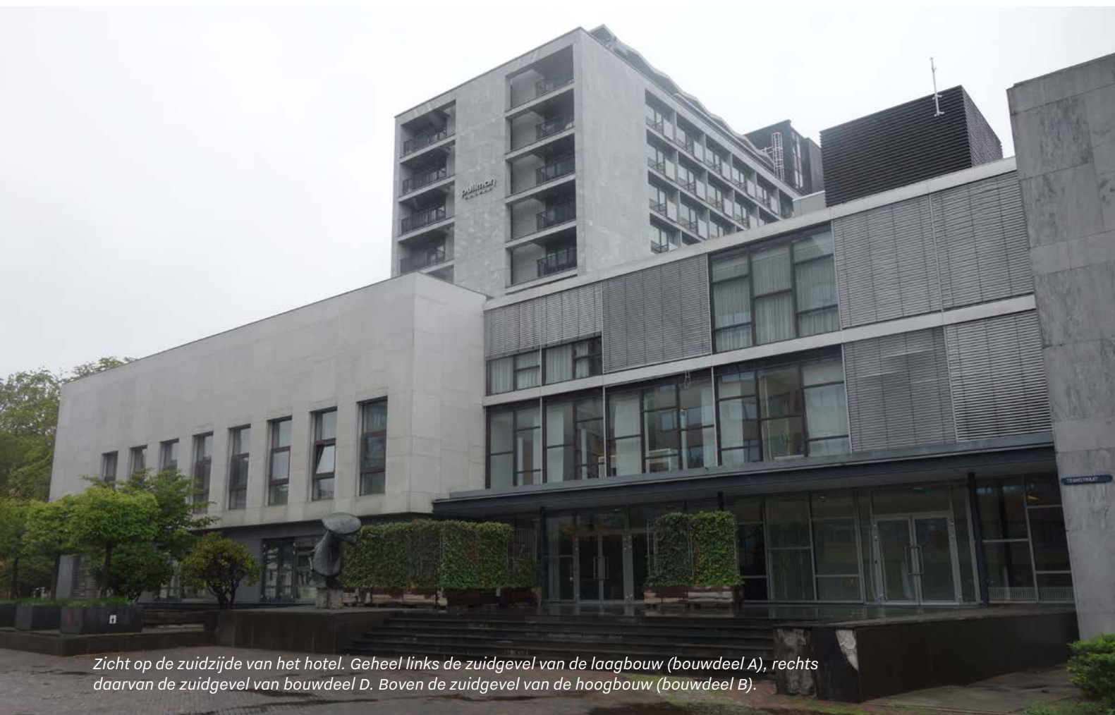
Zicht op de nieuw ingedeelde en nieuw beklede eerste bouwlaag van de laagbouw (bouwdeel A), zuidzijde.
