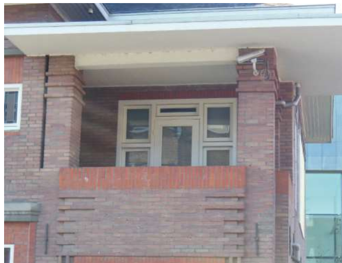
Op de verdieping ligt de gevel terug ten behoeve van een inpandige loggia. De gevel aan de voorzijde hiervan wordt gevormd door twee rechthoekige bakstenen kolommen. Beide kolommen zijn aan de bovenzijde voorzien van drie uitstekende baksteenlagen, die rondom de kolom aangebracht zijn. De linkerkolom staat overigens vrij van het geveldeel links daarvan. De rechterkolom lijkt visueel tot het straatniveau door te lopen.
