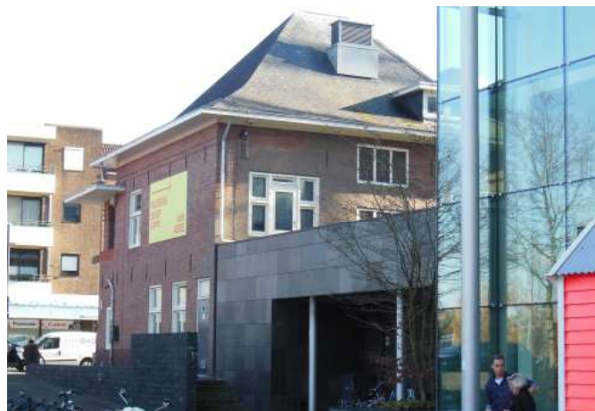
Links in de gevel een houten kozijnwerk, dat gelijk is aan dat in de loggia aan de voorzijde van het pand. Boven het kozijnwerk een anderhalfsteense rollaag. Ter hoogte van de balklaag tussen de verdieping en de zolder zijn drie staafankers zichtbaar.
