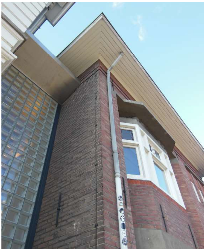
Centraal in de linkertravee van de voorgevel is een verdiepte, trapeziumvormige staande erker gebouwd. De vensteronderdelen van de erker op de begane grond zijn opgebouwd uit een trapeziumvormig houten frame met onder- en bovenramen.
